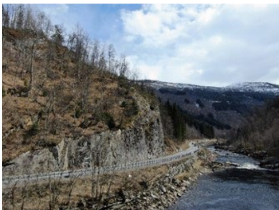
Figur 5 Oversiktbilete over eksisterande skjering Kvarmakløvet
