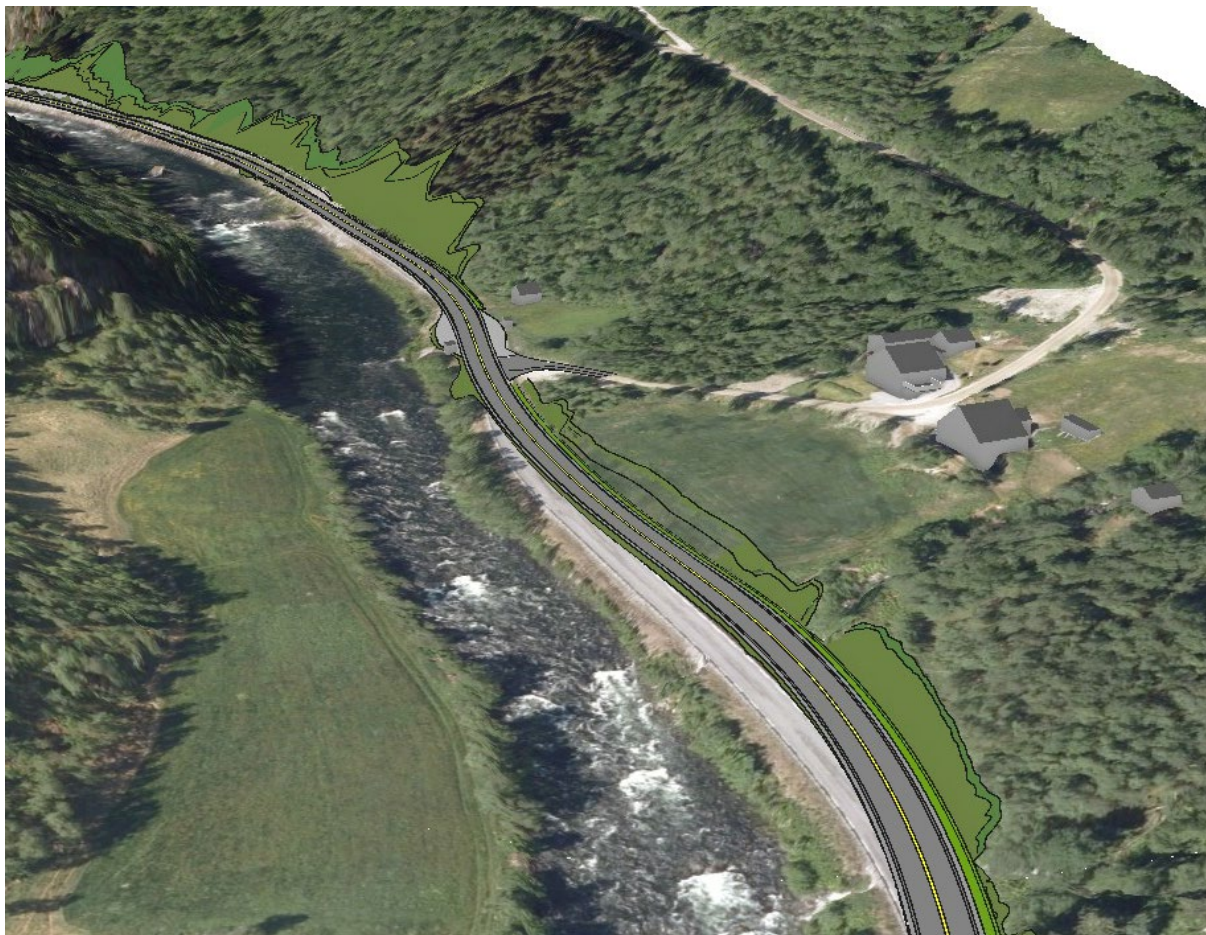
Figur 49 Ved Kvormo blir eksisterende busshaldeplass behalde. Veglinje går innover landbruksområde ved g/brn 310/1 for å oppnå trafikksikker veglinje
