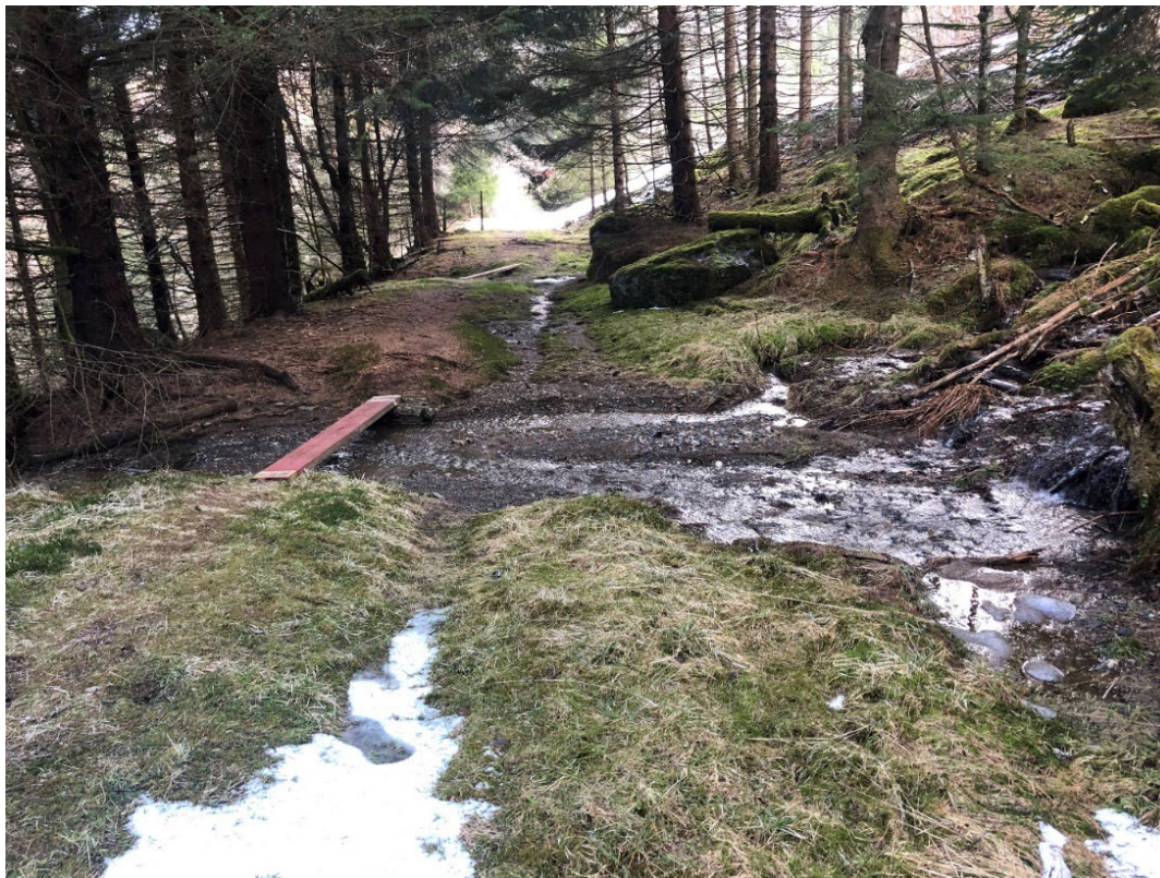
Figur 32 Den Bergenske kongevei. Biletet er frå delområde 1e. Dette delområdet er langt på veg intakt, men har fått skadar av vatn på avvege. (Foto: Marit Anita Skrede, 2021)
