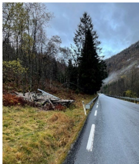
Figur 50 Nedfallen løe ved eigedom 75/6
