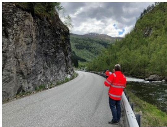
Figur 6 Eksisterande veg går i krapp kurve og med smale og grunne grøfter forbi Kvarmakløvet
