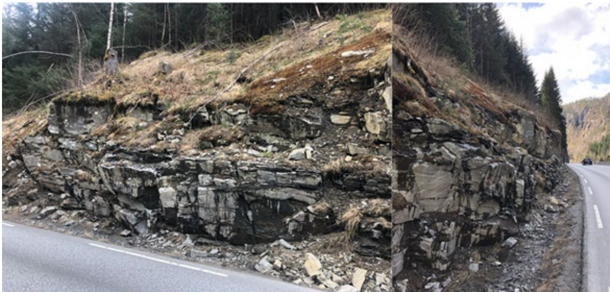
Figur 40 Bergskjeringa ved Rinden med tydeleg oppknust og forvittra dagfjell (Foto: Marianne Sundal)
