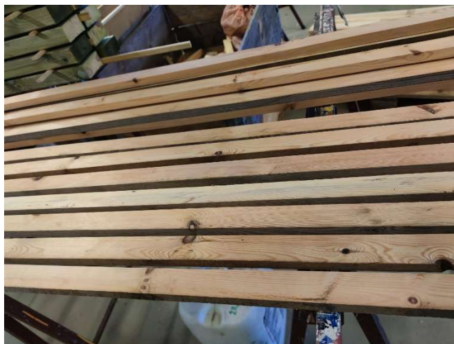
Spilevegg under arbeid.
