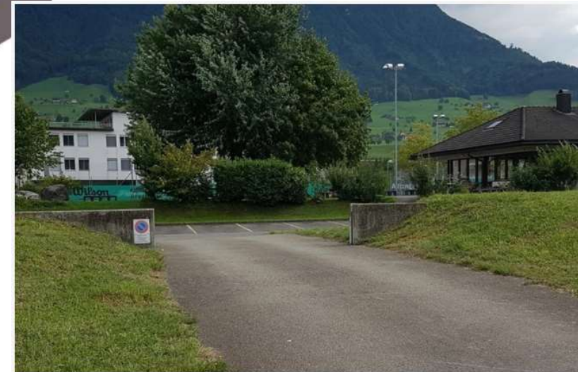
Figur 4: Eksempel fra Sveits på flomvoll som krysser vei og parkeringsareal og er basert på en kombinert løsning av voll, mur og vannrette bjelker som monteres mellom de to murdelene ved flom. (Foto: Martin Jespersen, NVE)
