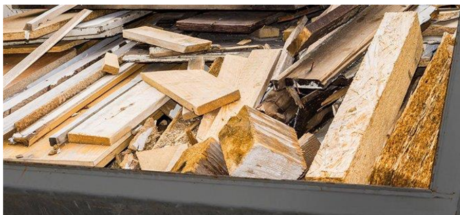
Figur 15: Container med sortert avfall på byggeplass. Kilde: https://blogg.norskgjenvinning.no/hvordan-lykkes-med-kildesortering-pa-byggeplassen
