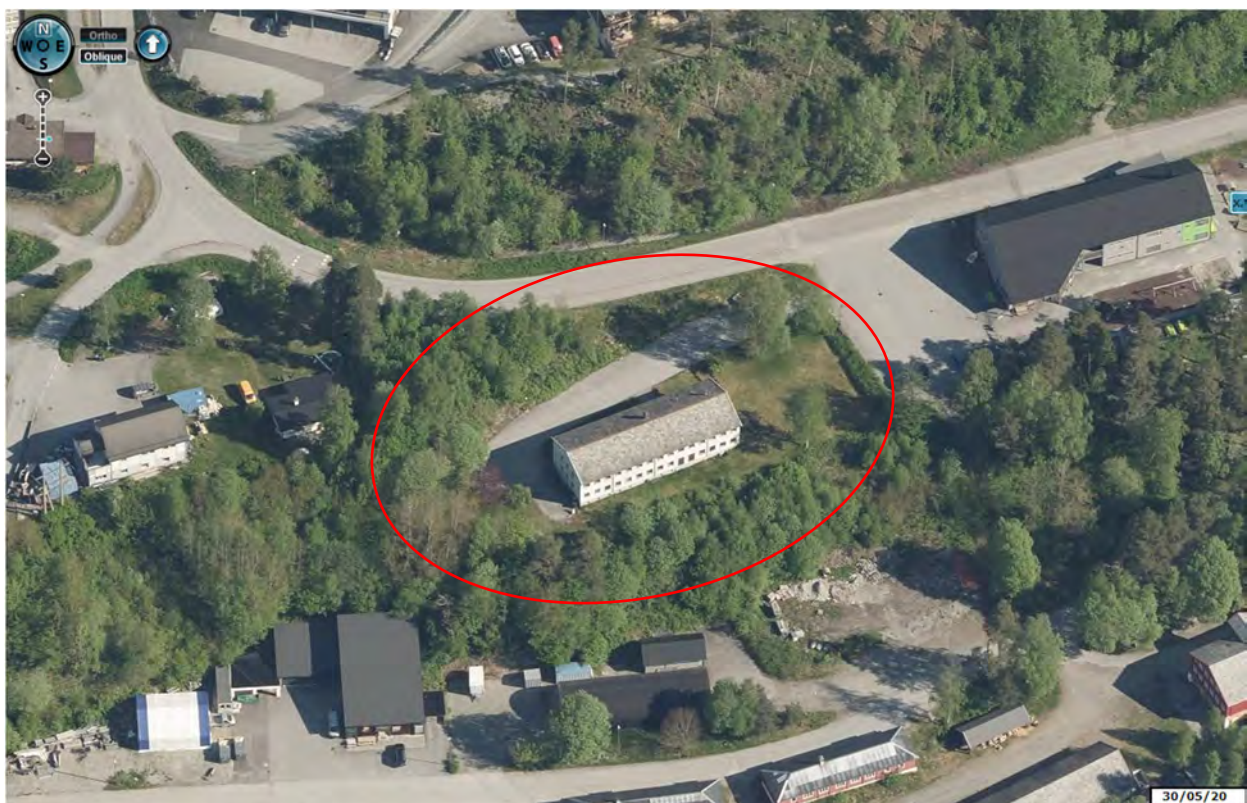
Figur 5, Skråfoto av området sett frå sør
