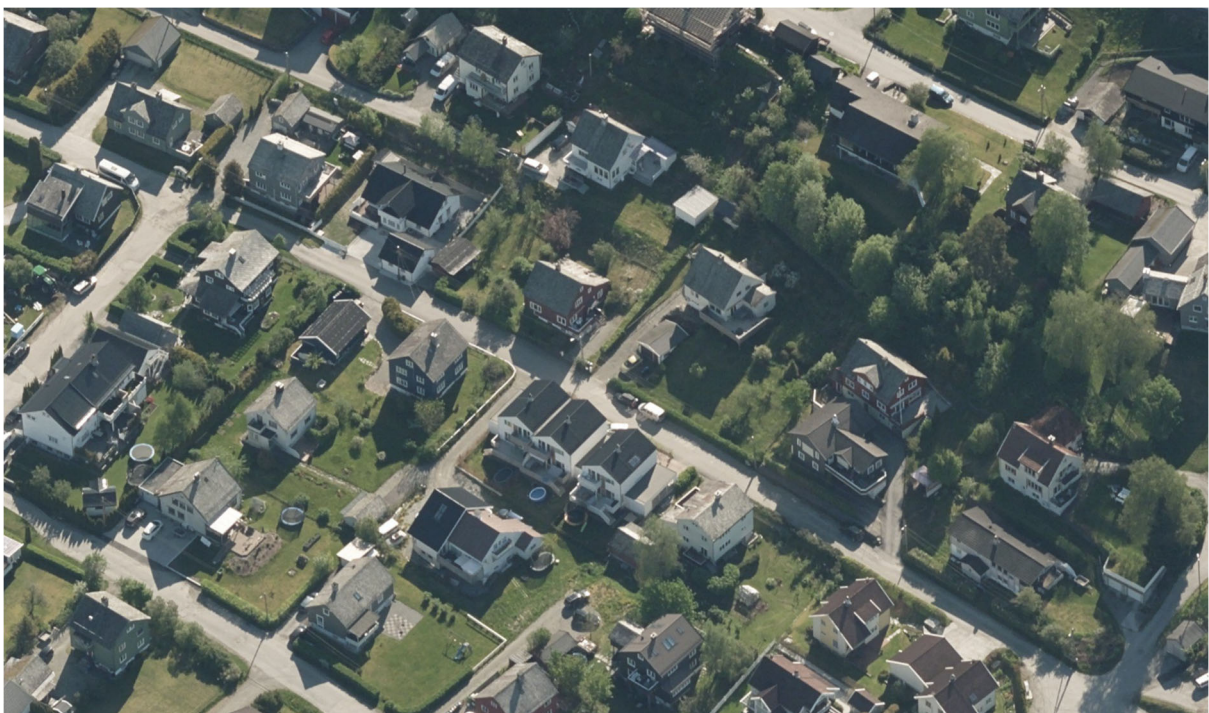
Skråfoto av området sett fra vest
