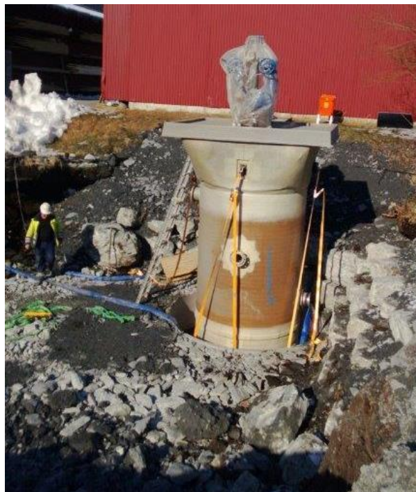
Figur 7: Ny pumpestasjon Storrviki (foto: Jakob Håheim)
