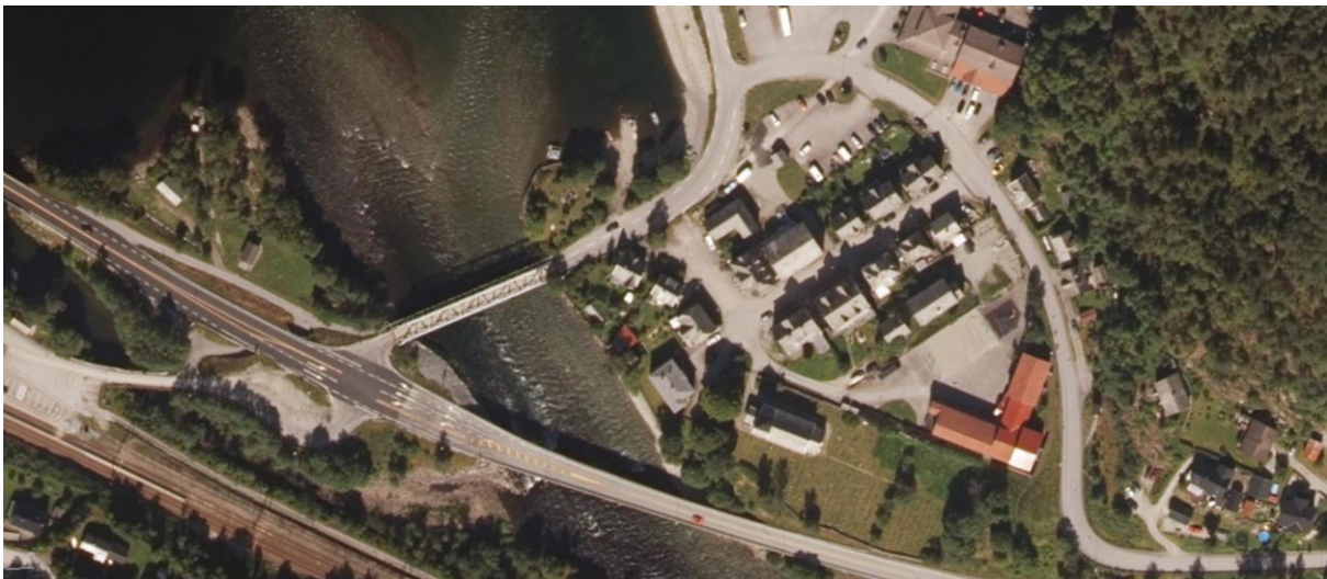
Figur 5. Morfodynamikk på Evanger der Voss munner i Evangervatnet, flyfoto fra 1958, 2013 og 2020 (norgebilder.no). Elvestrekningen er massebegrenset og det vil akkumuleres sediment over tid. Trolig forekom utgravinger mellom bildene. Legg også merke til utfylling nord for Evanger der det ble skapt arealer med stor risiko for oversvømmelse.
