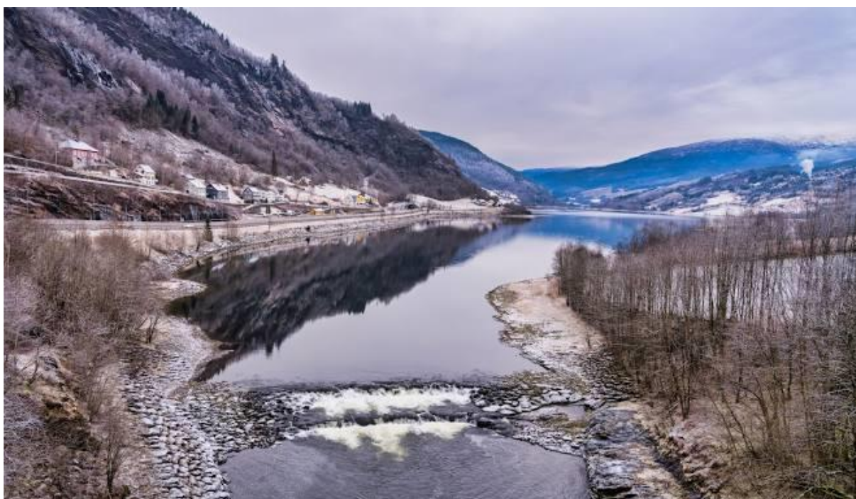
Figur 32. Utløp av Vangsvatnet ved Bulken med utløpsterksel og plastrede elvebredder fra 1992.
