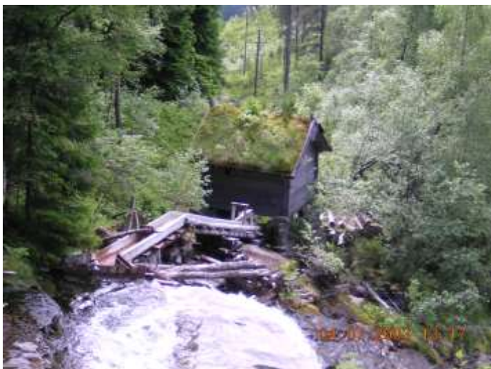
Restaurert mylne på Mugås (Foto: Sigrunn Dommarsnes)
