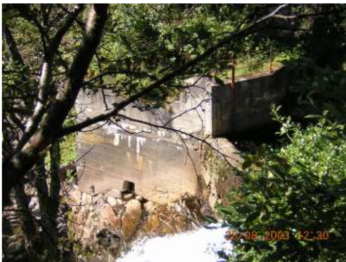
Ei demning med samband til det elektriske kraftverket på Stalheim (Foto:Sigrunn Dommarsnes)
