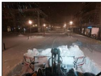
Snøbrøyting KV1069 Vangsgata
