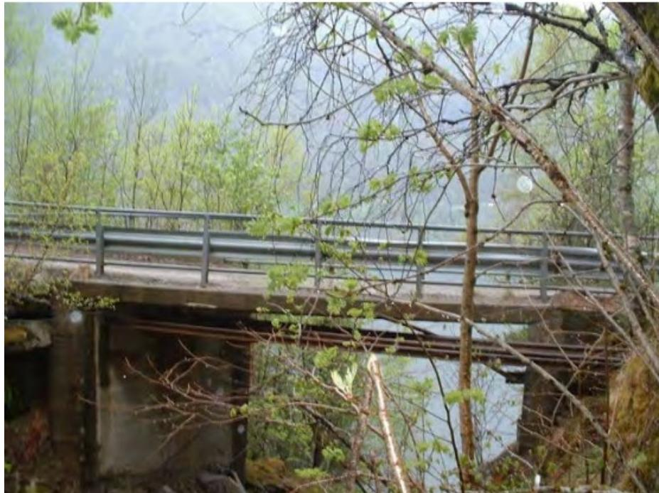
Brua er ei betong platebru med spennlengde på 7,10m. Landkara, lageravsatsar og bakveggar består av betong..
