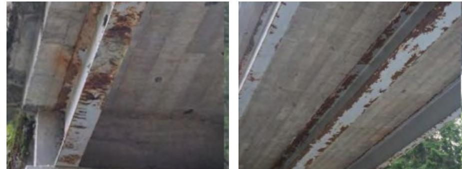
Underkanten av brudekke er prega av fuktbelastning og avskalling. Det ser ut som at armeringen har svært liten overdekning.
