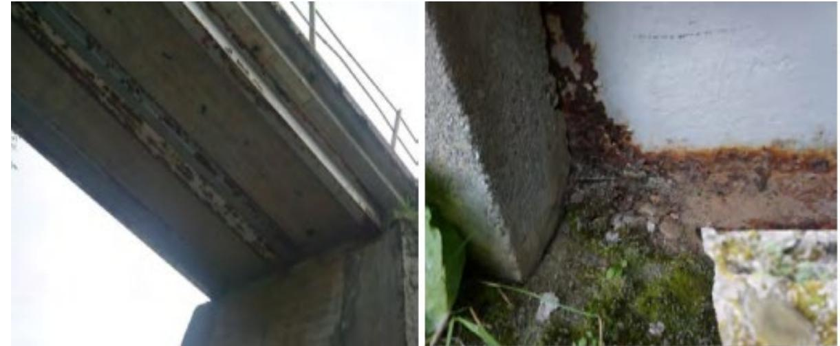
Bjelkane har skade på overflatebehandling, og har kraftig korrosjon på underflens spesielt ved opplagring. Det er mangelfullt med avstiver mellom bjelkane.
