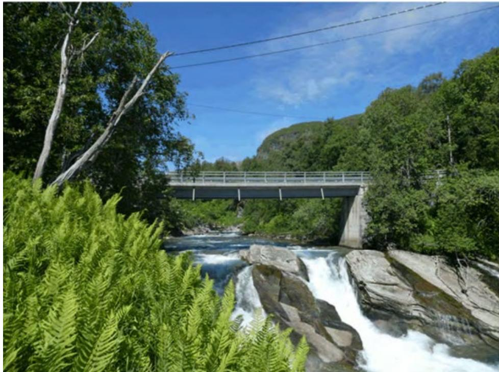
Brua består av stålbjelke med betongdekke i det eine spennet på 21,4 meter og betongbjelkebru med 7,7 meter spenn. Hovudbærende elementar er stålbjelkar og betongbjelkar.
