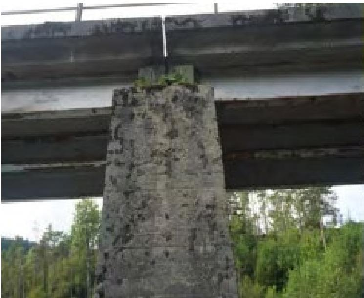
Det har oppstått avskaling og forvitring av betong på pilaren. Det er litt begroing / mose i øvre del
