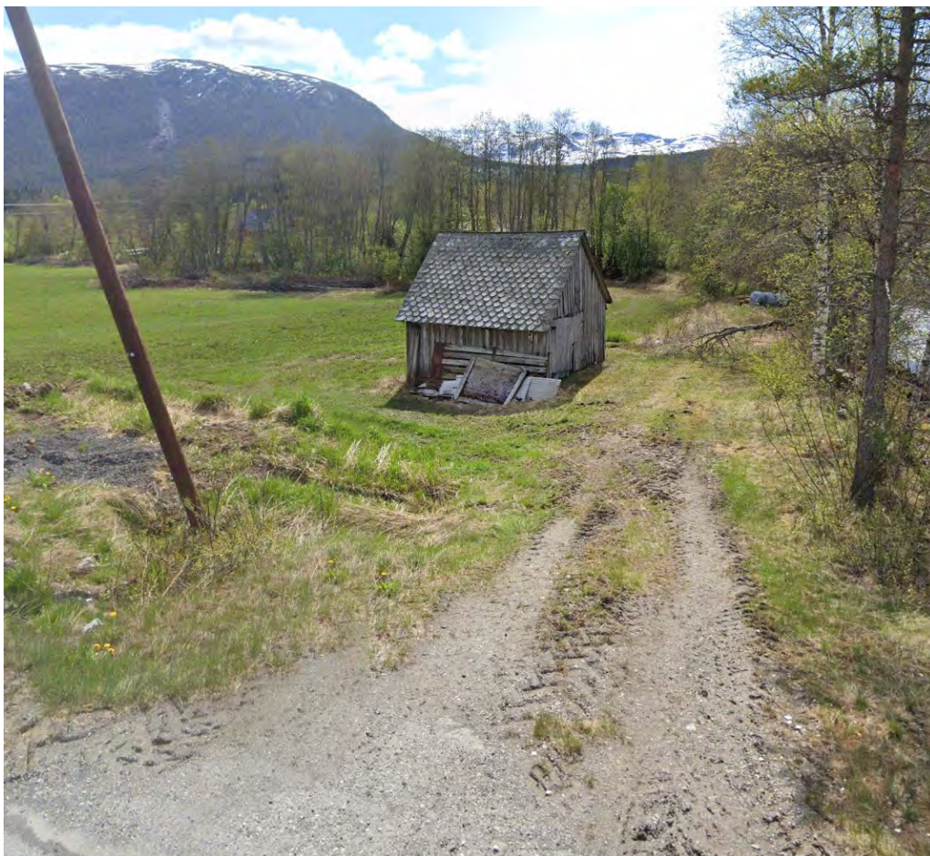
Figur 23 Skiferkledd uteløe ved profil 1400
