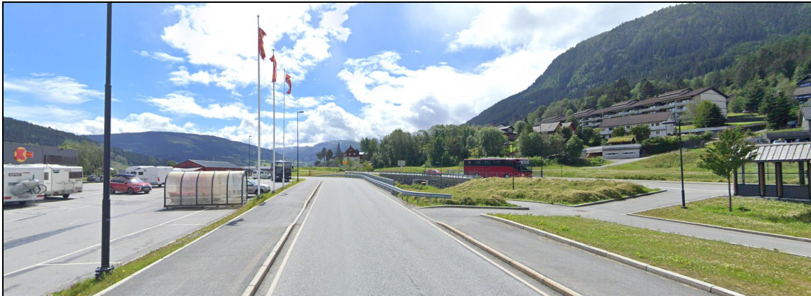
Figur 14. Det er også tosidig fortau langs Fv.5390 Nedkvitnesvegen og tilrettelagt kryssingspunkt mellom butikken og busstoppet/gangveien langs E16. Foto: Google.
