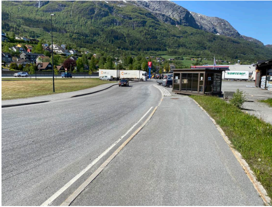
Figur 13. Fortau på kvar side av Kv.1122, Storrviki, og tilrettelagt kryssingspunkt (nedsenka kantstein).
