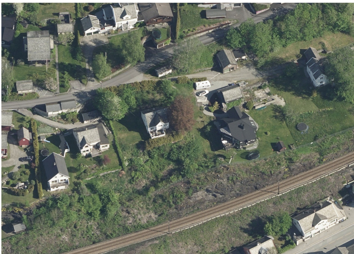
Figur 5, Skråfoto av området sett frå sør
