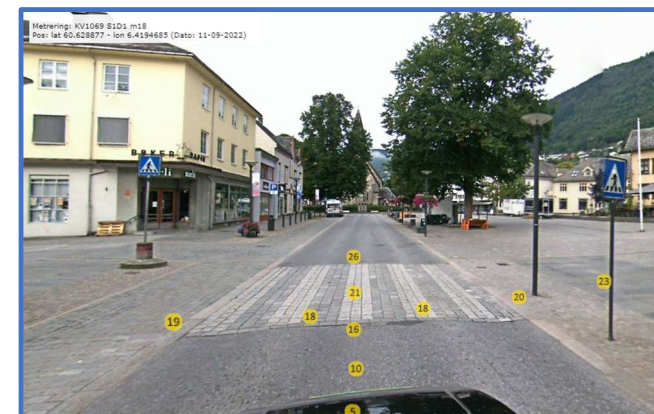
Foto: KV1069 Vangsgata
