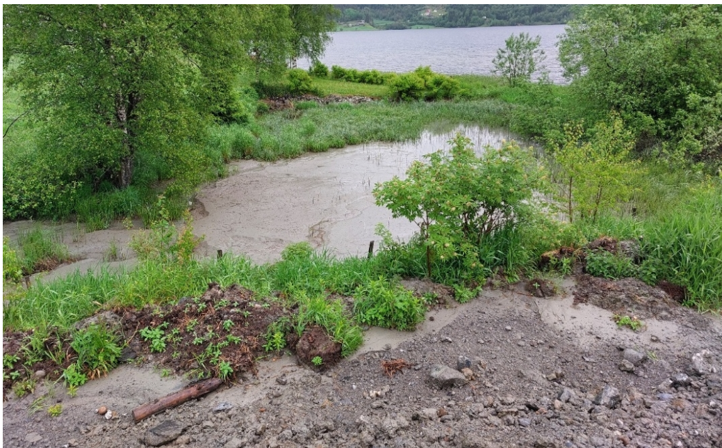
Figur 6 Bilde frå synfaring mai 2025, syner at det er glidd ut massar inntil våtmarksområde mot nord. Toppen av gjerdestolpane er synlege i grensa. I pollen bak er det fylt opp med slam frå massane.
