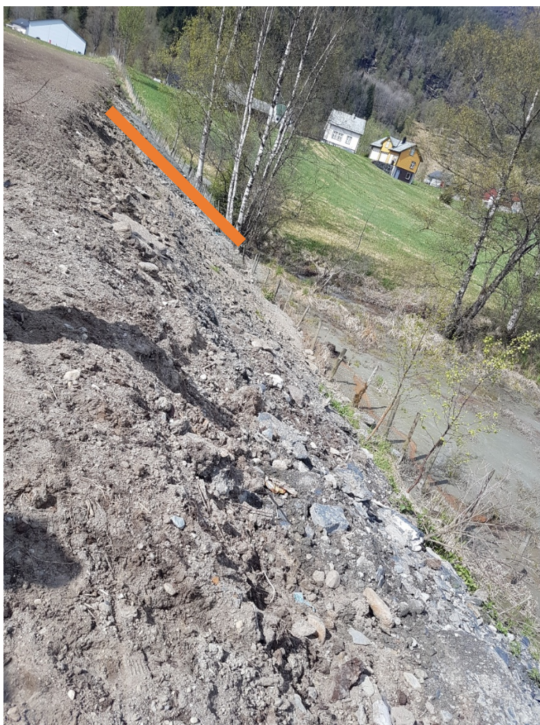
Figur 7 Bilde frå synfaring mai 2026. Fyllingsfoten er plassert inntil gjerdet mot 66/15. Løne anslår fyllingshøgd til om lag 1,5 meter. Voss herad har ikkje gjort egne målingar, men finn 1,5 m som eit konservativt anslag.
